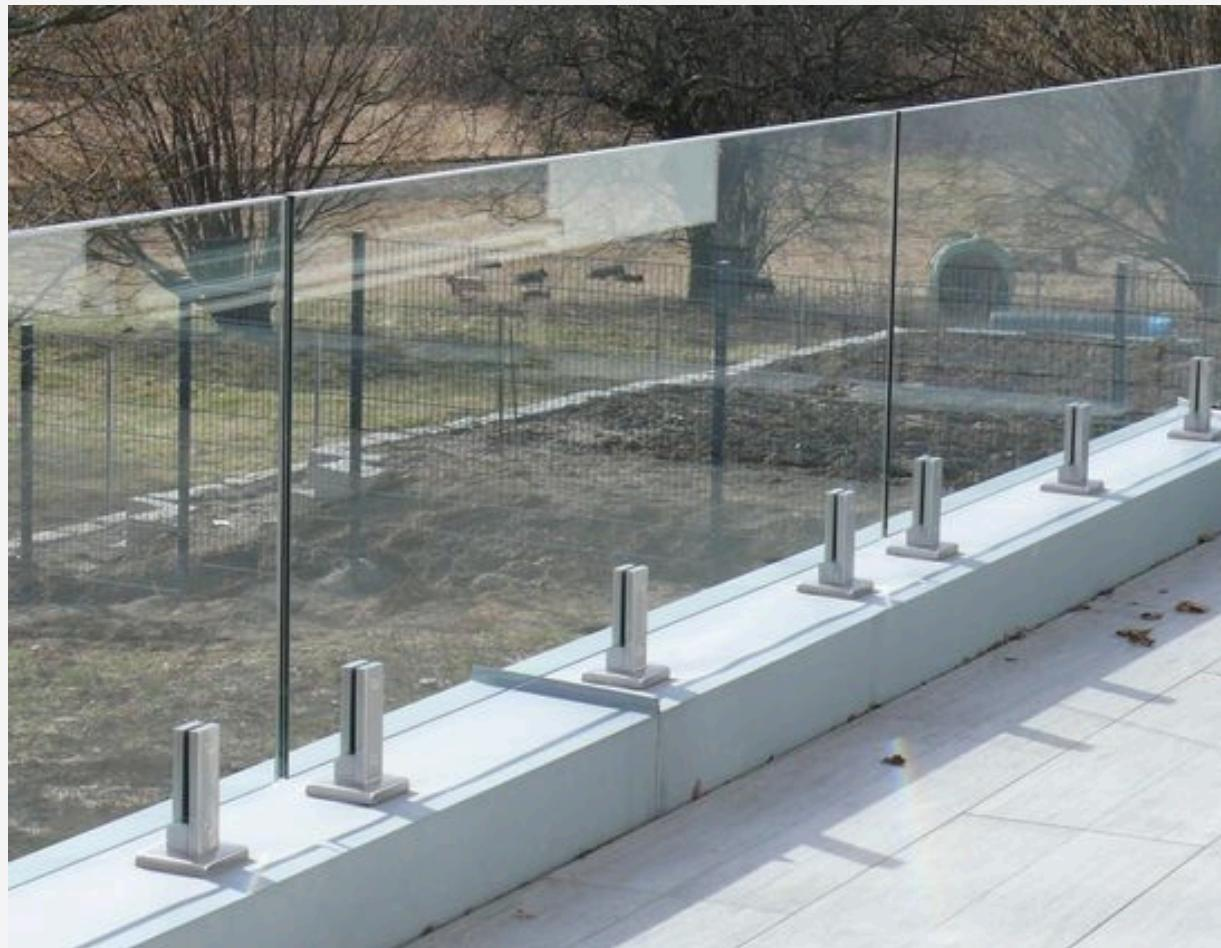
Sistema de baranda compuesto por postes de baja altura, diseñado para ofrecer un equilibrio ideal entre seguridad, diseño y transparencia. Los mini postes permiten sostener el vidrio de forma firme y ordenada, manteniendo una estética moderna y limpia, sin perder presencia estructural.
